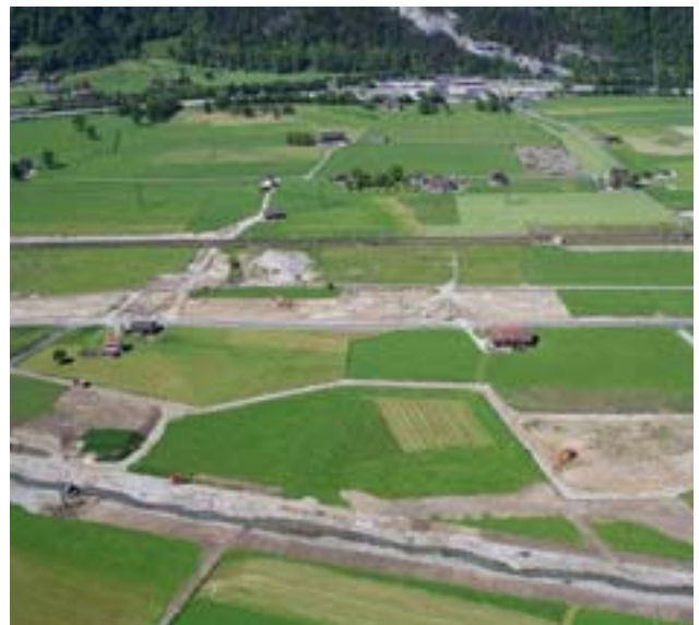
Grossflächige Kulturerdearbeiten in den Baulosen 002 und 005, Teilabschnitt Altdorf/Rynächt, NEAT, 2007
