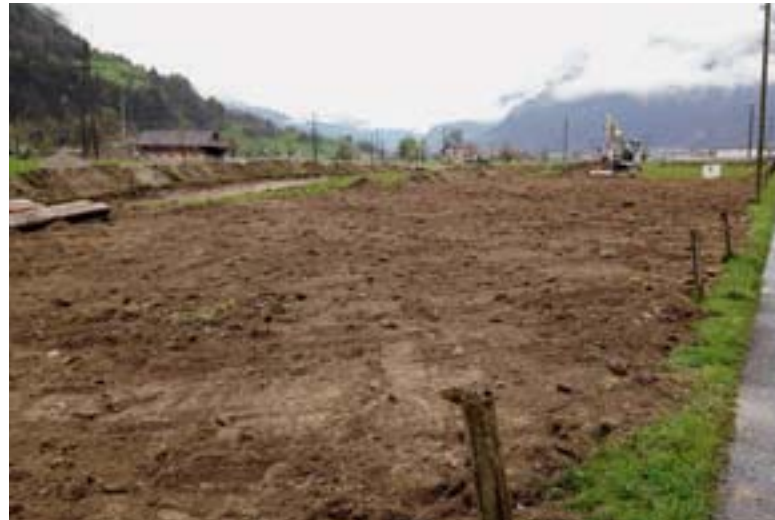
Bodenauftrag, Bodenverbesserung Feldmatt in Erstfeld, 2012
