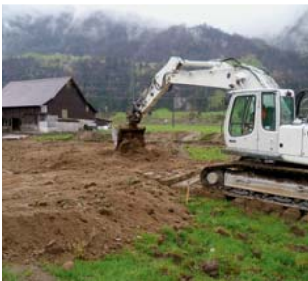
Schüttung von Bodenmaterial auf festgelegte Zielhöhe. Bodenverbesserung Feldmatt in Erstfeld, 2012
